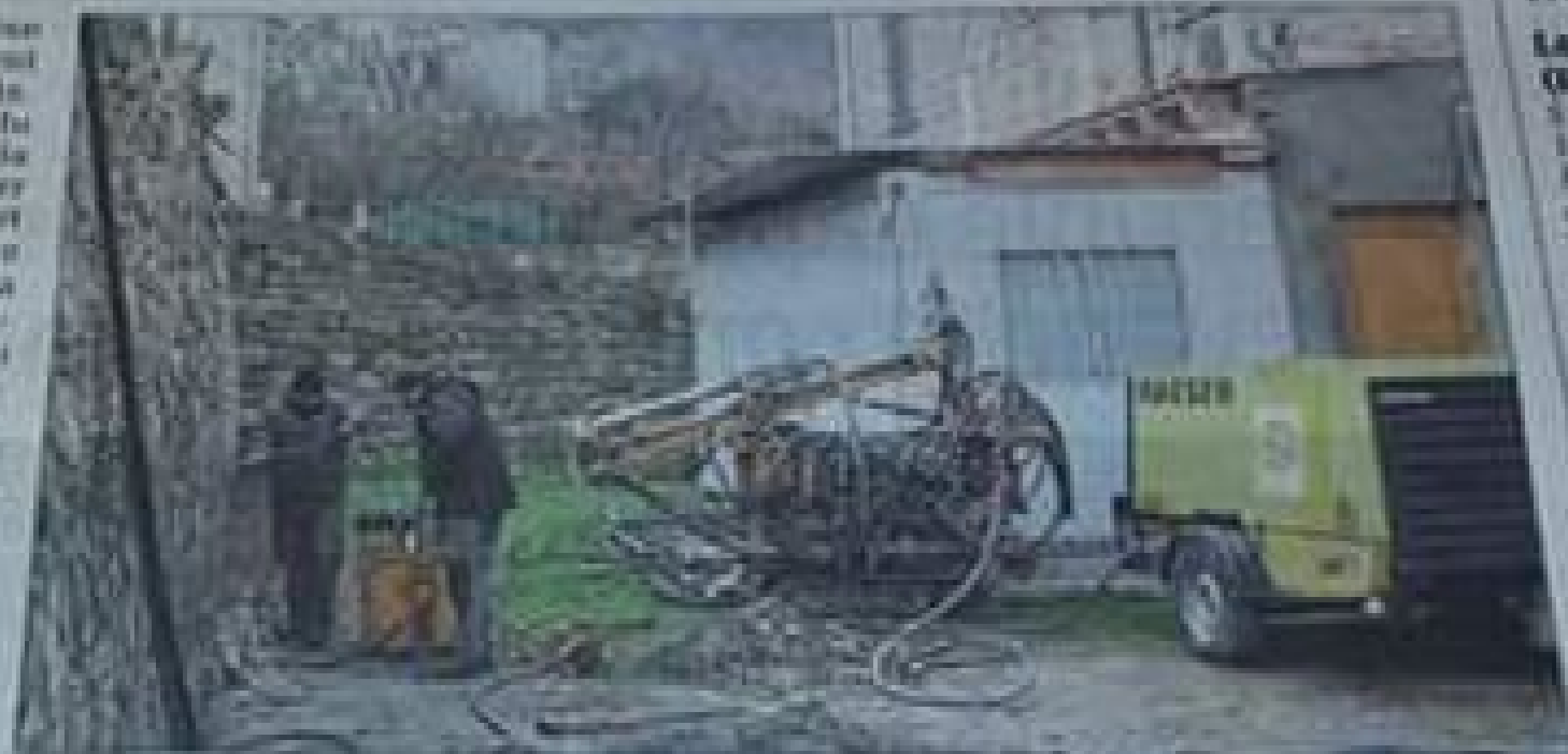
Les travaux très spécifiques vont permettre de garder les pierres d'origine de la mairie. PHOTO LE
