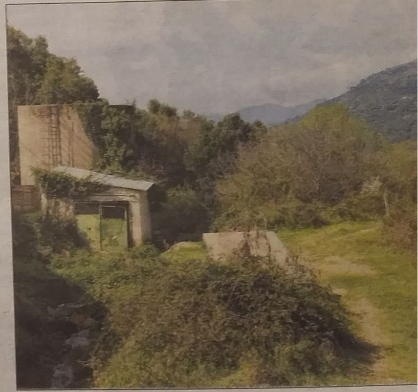
L'étude préliminaire a été réalisée au niveau du ruisseau de proximité de l'ancienne station d'épuration.
